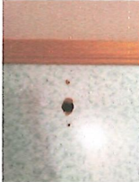
Sondage der Dekorplatten in WC/Küche Anl. Whg.
